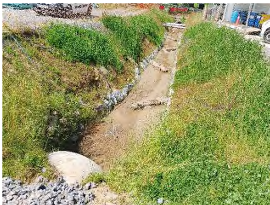
Foto nº10: Biorrollos en ODTC-02
