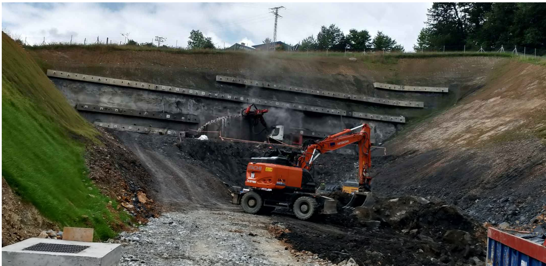
EMBOQUILLE ETXEBARRIA + EJE 21
