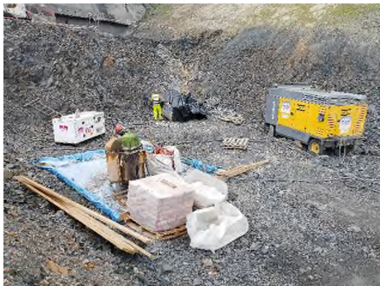
Foto nº8: Zona auxiliar de inyección para el emboquille de Etxebarria
