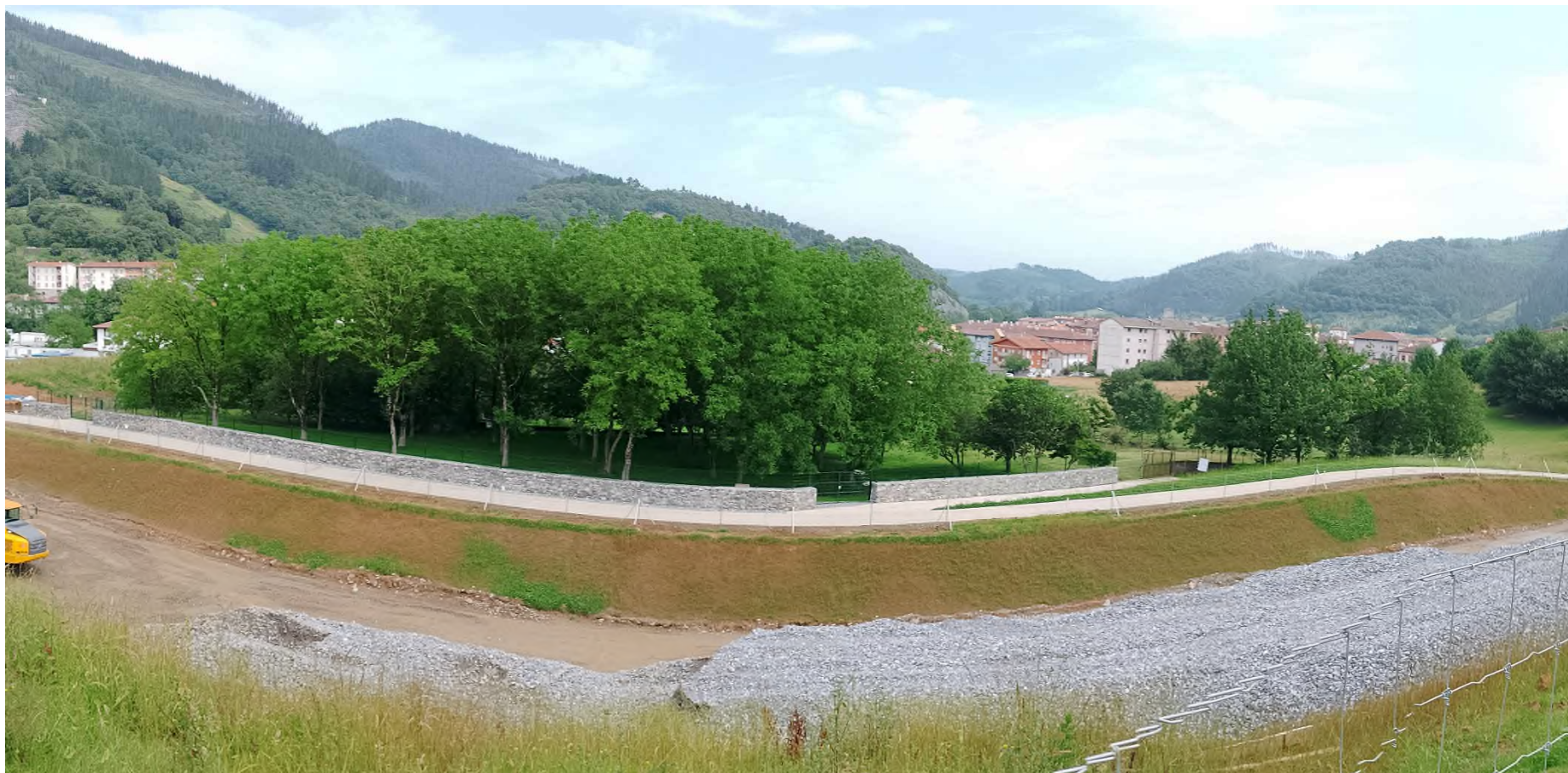
EJE 19, MURO DE MAMPOSTERIA Y CERRAMIENTO
