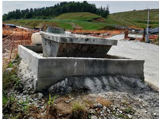
Foto nº7: Limpieza de canaletas en Markina
