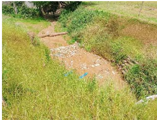
Foto nº23: Barreras habilitadas en ODT-04
