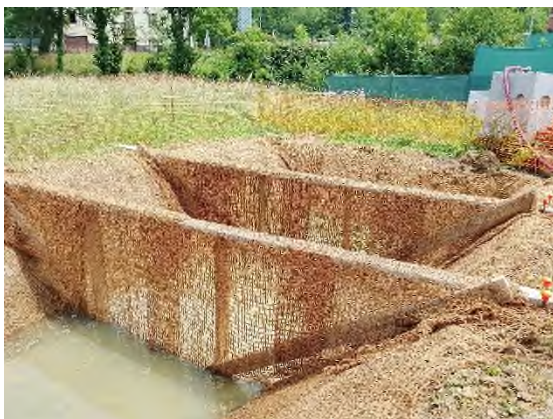
Foto nº1: Balsa decantación Etxebarria
