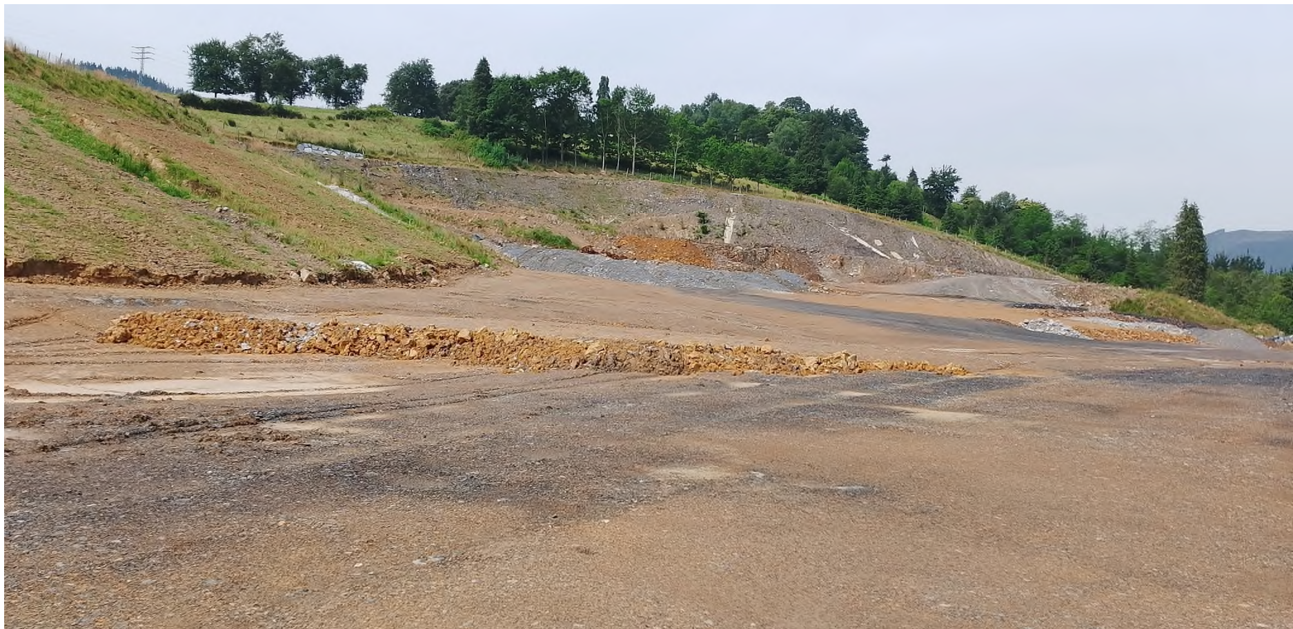
ZONA SUPERIOR DE RELLENO DEL DEPOSITO DE SOBRANTES
