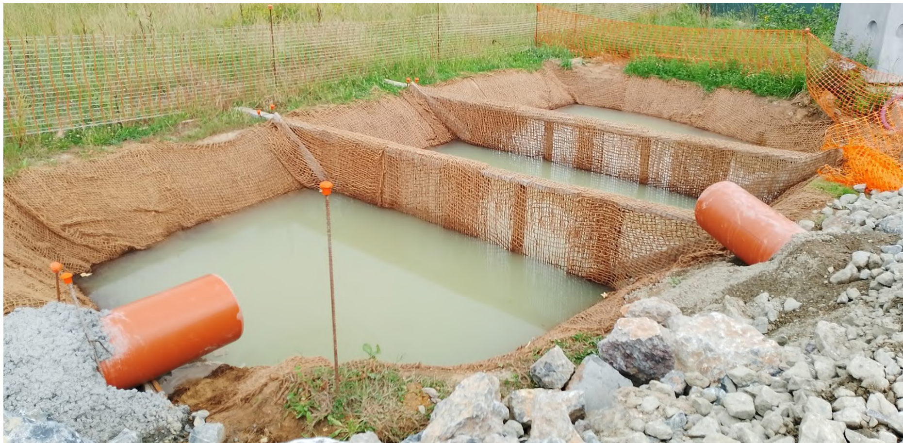
NUEVA Balsa de decantación Etxenerria
