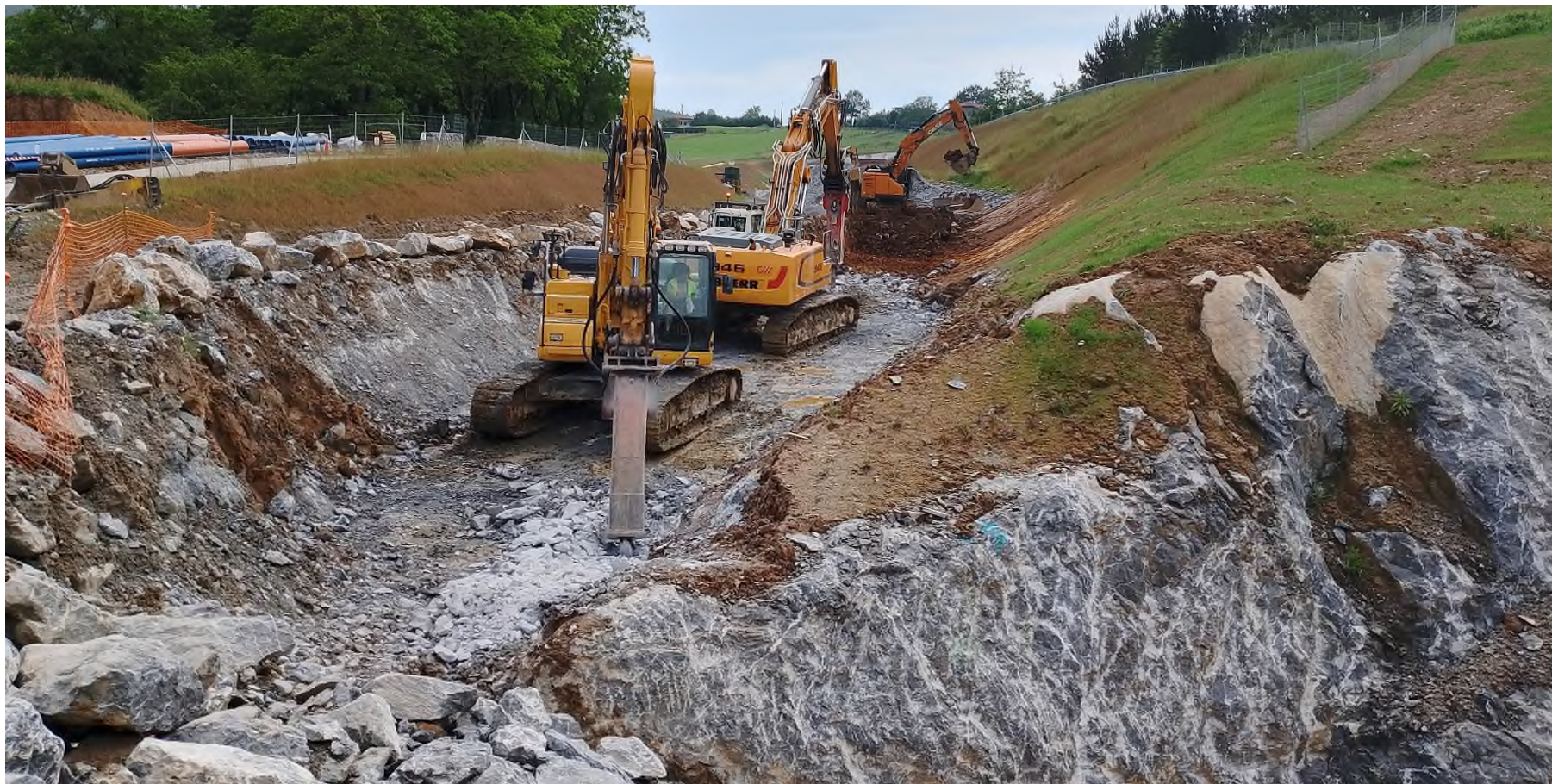
EXCAVACIÓN Y ESCOLLERA EJE21 MARKINA
