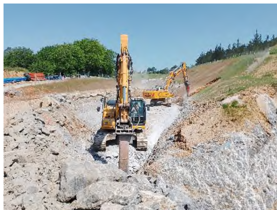
Foto nº2: Excavación Eje-21 Markina
