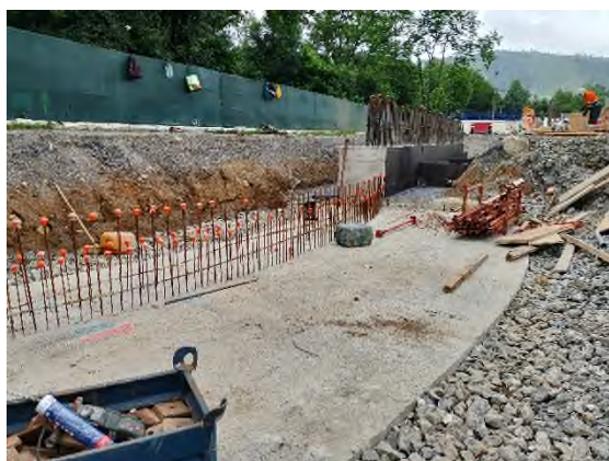
Foto nº16: Valla opaca zona antiguo vial
