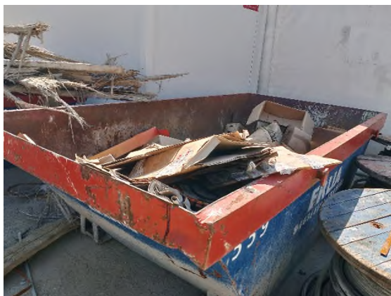
Foto nº12: Almacenamiento de RNP emboquille de Markina
