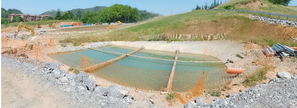
Foto nº3: Balsa de decantación del DS
