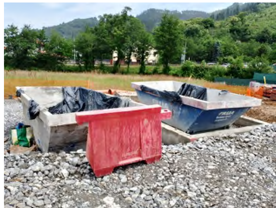
Foto nº9: Limpieza de canaletas de los estribos
