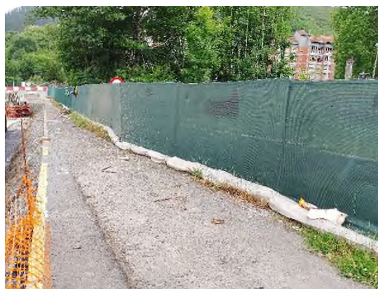
Foto nº17: Valla opaca, biorrollos y geotextil zona antiguo vial.
