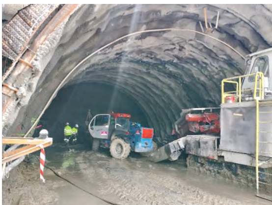
Foto nº7: Túnel emboquille Markina
